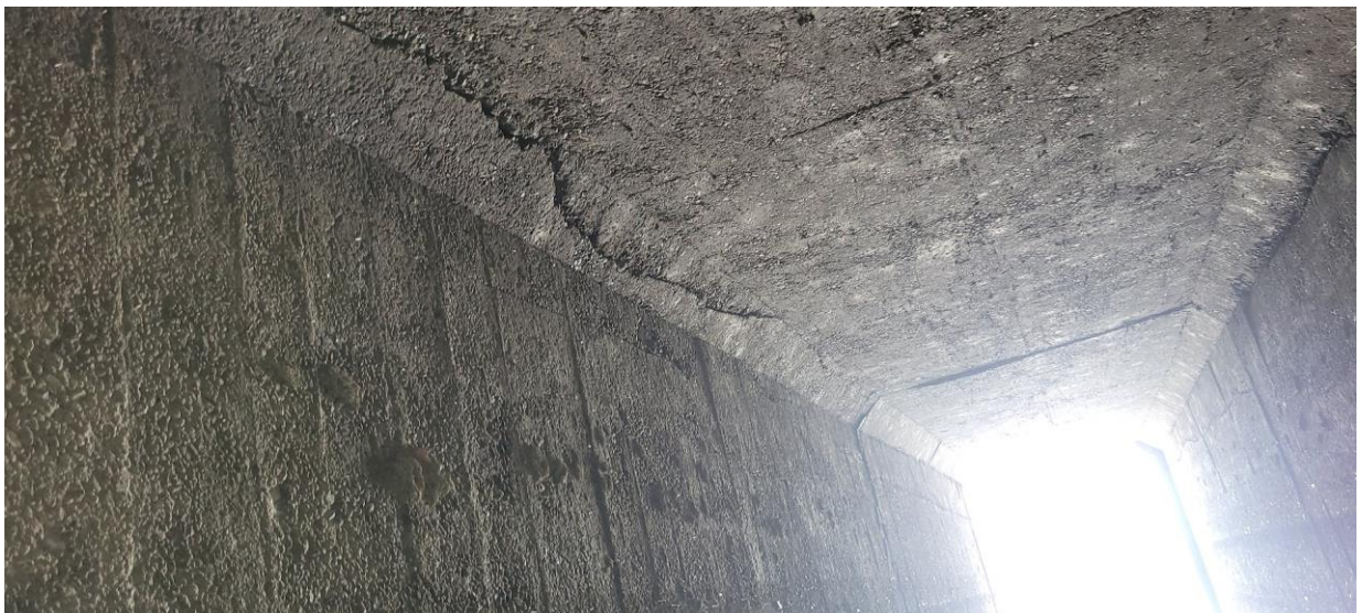
Hình 4: Trần cống bị thấm, mất an toàn
