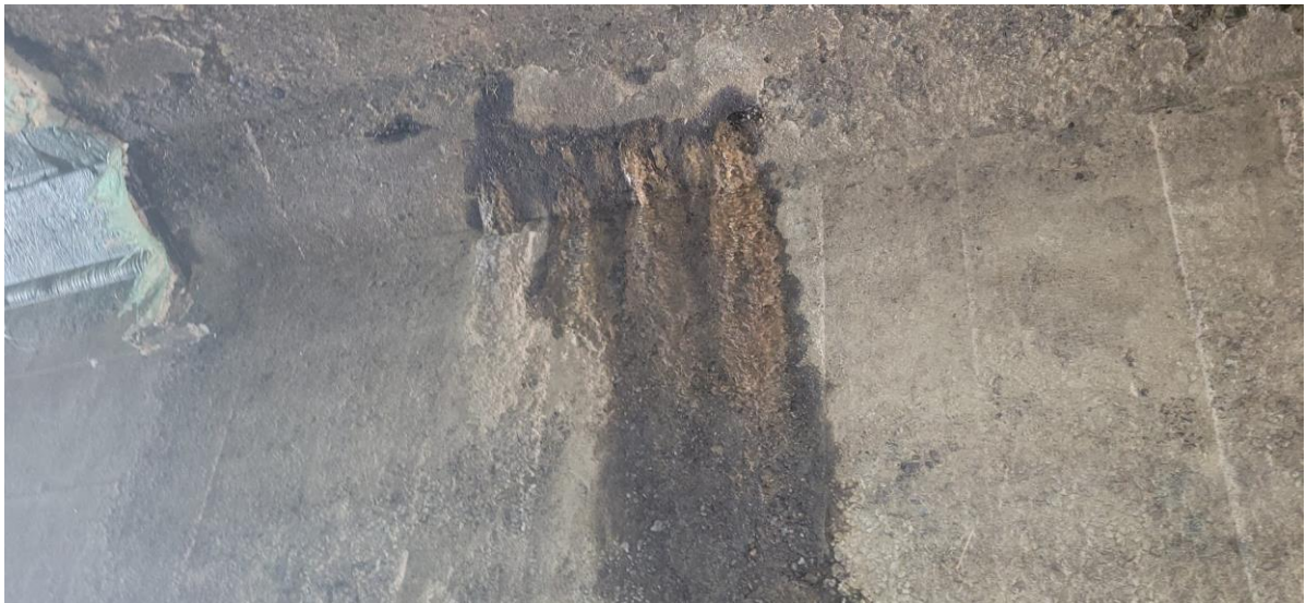
Hình 4: Trần cống bị thấm, mất an toàn
